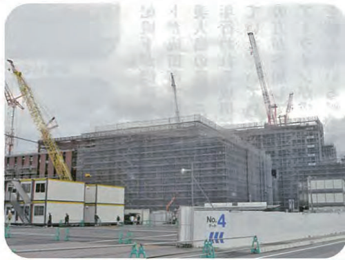
新駅構想に続く建設中の医療福祉大学附属病院
